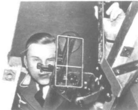
Während der Ausbildung wird der Bombenwart immer wieder geübt, bis er völlig „steif“ ist. Hier die Arbeit an einfachen mechanischen Bombenzielgeräten. Die Auslösung der Bombe erfolgt von Hand.
